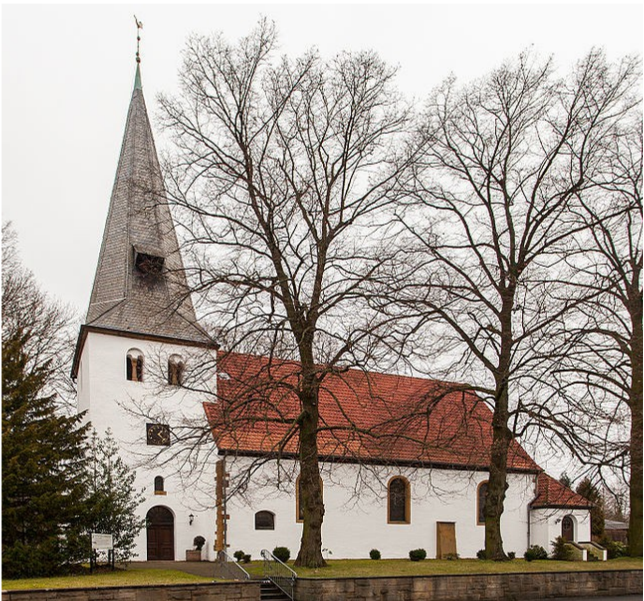
Pfarrkirche St.-Gangolf zu Hiddenhausen
